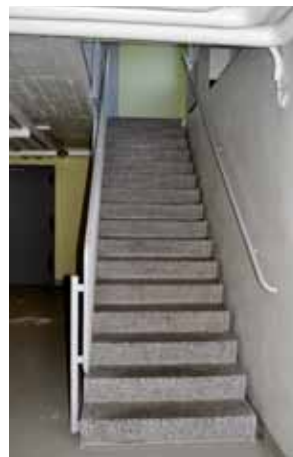
Det finns bara trappa till källarplanet.
