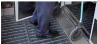
Även små trösklar försvårar framkomligheten
